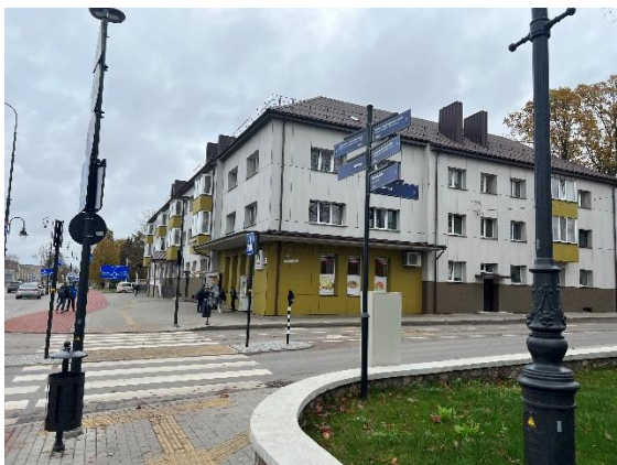
2 pav. kaimyninis pastatas- renovuotas daugiabutis namas
